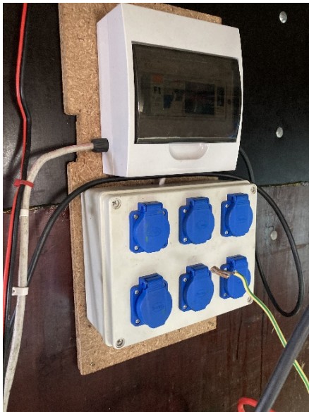
AC Stromkasten und Mehrfachsteckdose Versorgung Camp
